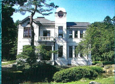
重要文化財 旧池田家住宅洋館
